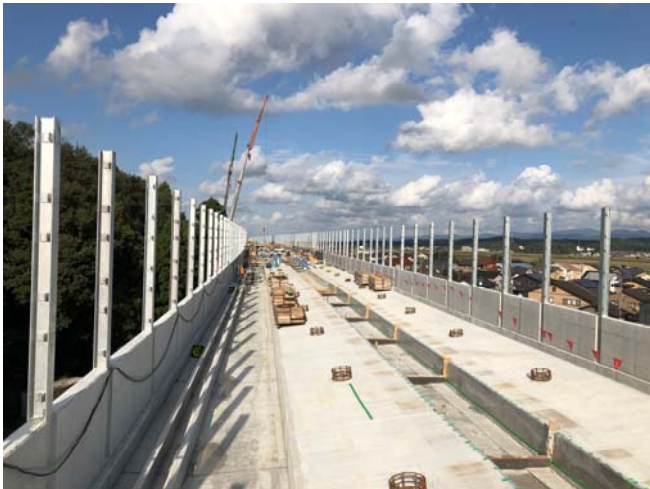
橋面作業状況
