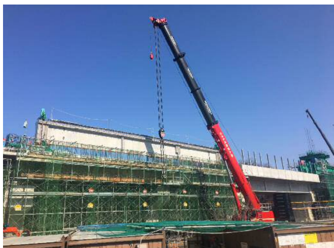
橋けた引出し状況
