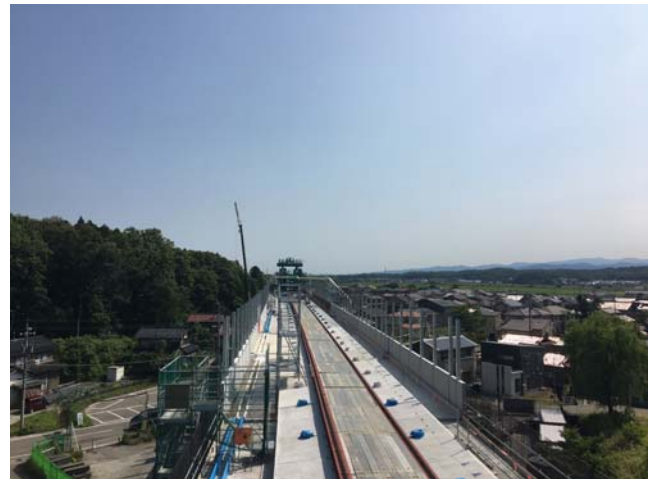
橋面施工状況
