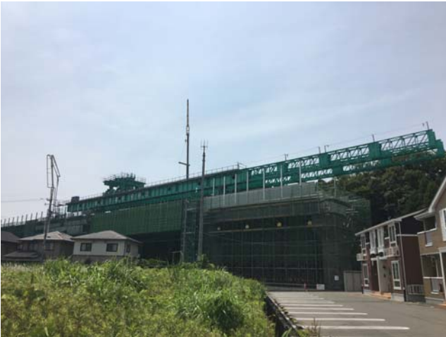
橋けた架設状況
