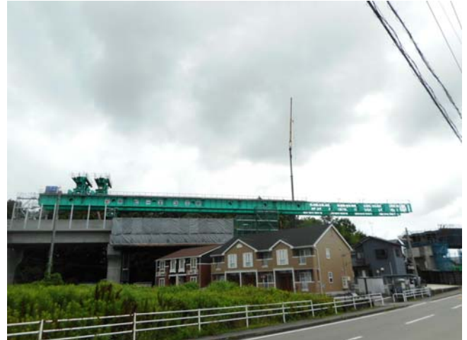
橋けた架設状況
