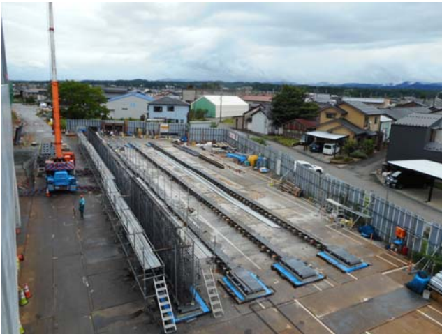
橋けた製作状況
